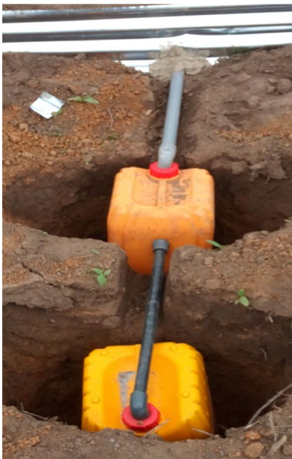
Figure 6 : Mise en place du système récepteur
